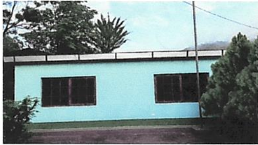
Foto 7: Fabricación e instalación de dos ventanas de metal al frente del salón remozado
